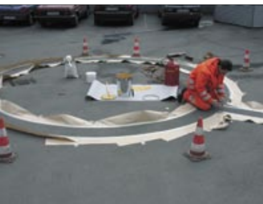
Aufbringen der Bodenmarkierung
